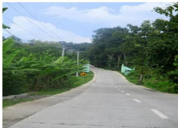
Gambar 1. Akses menuju Tebing Breksi yang sudah dibangun
